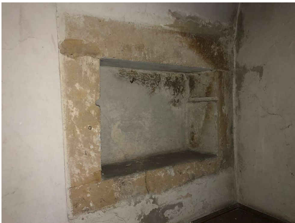
Fot. nr 6 Zabytkowa kamieniarka we wnętrzu „Domu Ariańskiego” w Pińczowie. Widok jednego z czterech tożsamyh obramień wnek. Stan zachowania w lipcu 2020 roku.
