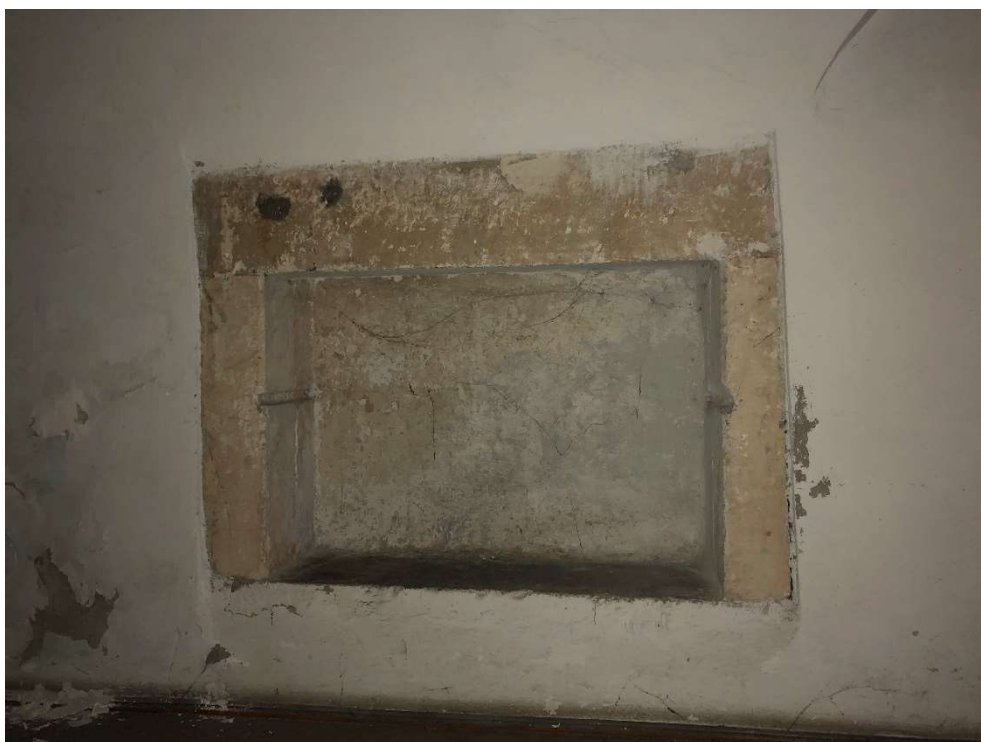
Fot. nr 7 Zabytkowa kamieniarka we wnętrzu „Domu Ariańskiego” w Pińczowie. Widok jednego z czterech tożsamyh obramień wnek. Stan zachowania w lipcu 2020 roku.
