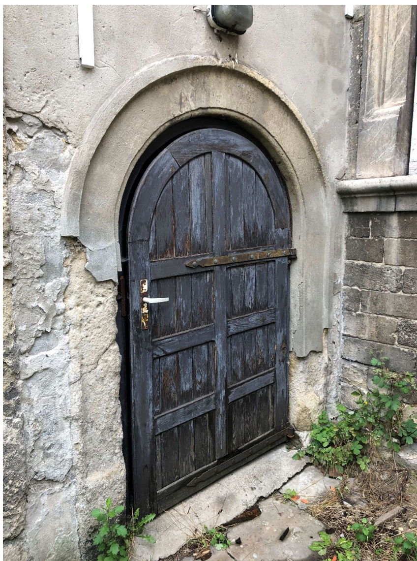
Fot. nr 2 Elewacja południowa „Domu Ariańskiego w Pińczowie” z przełomu XVI/XVII w. Widok portalu narożnego przylegającego do elewacji południowej. Stan zachowania obiektu w lipcu 2020 roku.
