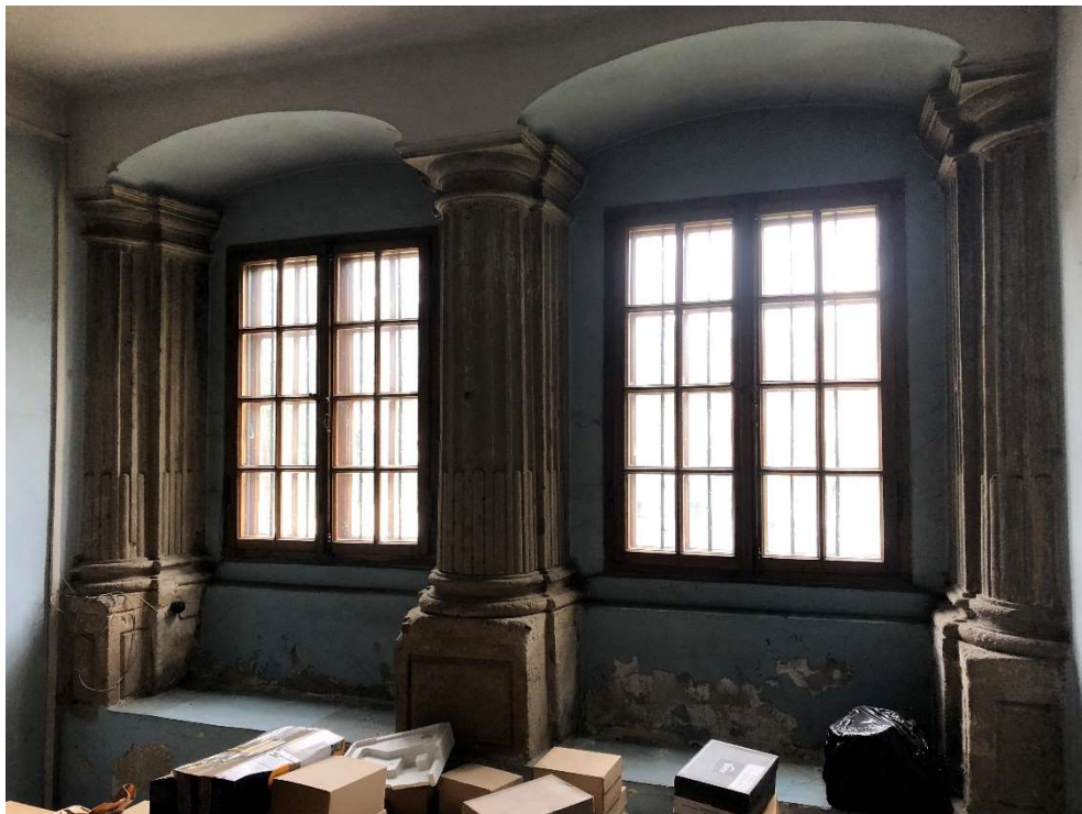
Fot. nr 5 Zabytkowa kamieniarka we wnętrzu „Domu Ariańskiego” w Pińczowie. Widok kolumn przyokiennych w pomieszczeniu z kolumnami. Stan zachowania w lipcu 2020 roku.
