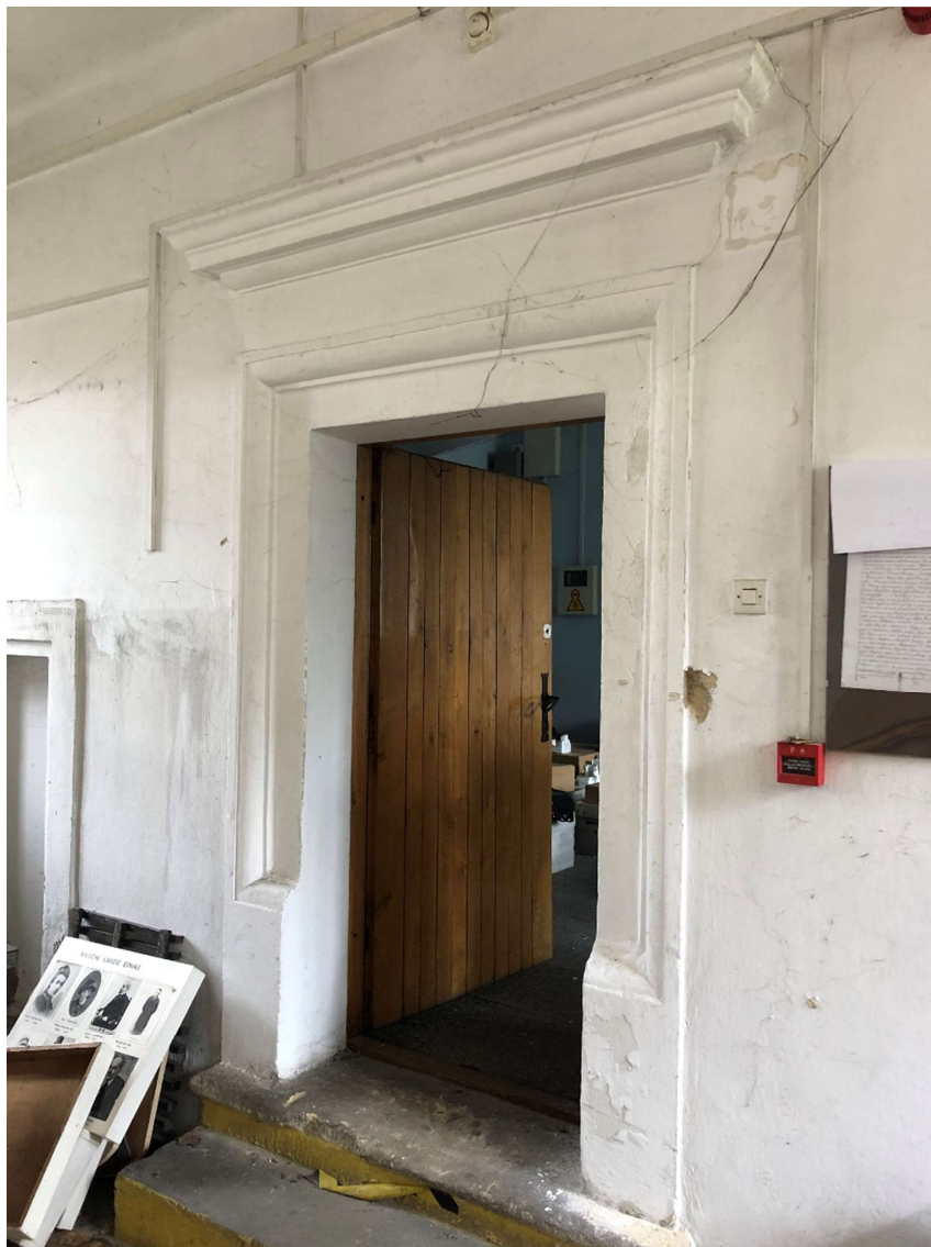
Fot. nr 3 Zabytkowa kamieniarka we wnętrzu „Domu Ariańskiego” w Pińczowie Widok portalu w sieni. Stan zachowania w lipcu 2020 roku.
